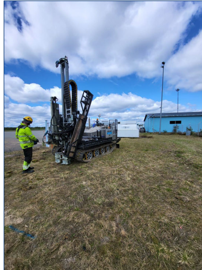
Kuva 2. Tutkimuspisteen P3 kairausta öljynerotuskaivon läheisyydessä.
