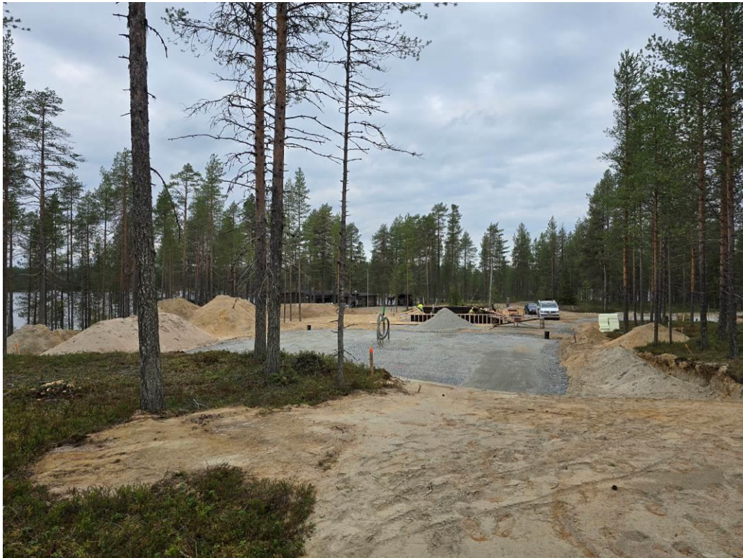
Kuva 10 Korttelin 3 rakennustyömaa (Kuva: Kimmo Mustonen 12.9.2024)
