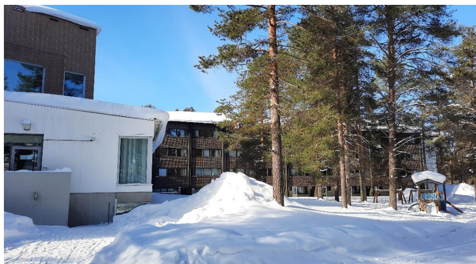
Kuva 8 Tropiikin kylpylähotellin pääosin tiililaattajulkisivuinen hotellilaajennus on valmistunut 90-luvun lopulla.
