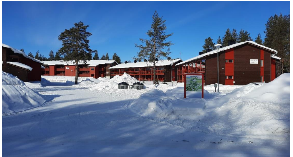
Kuva 10 Kylpylätien varrella sijaitsevat 2010-luvun lopulla rakennetut luhtitalot. Tummanruskeassa puujulkisivussa on muista alueen rakennuksista poikkeavasti käytetty punaista tehosteväriä.
