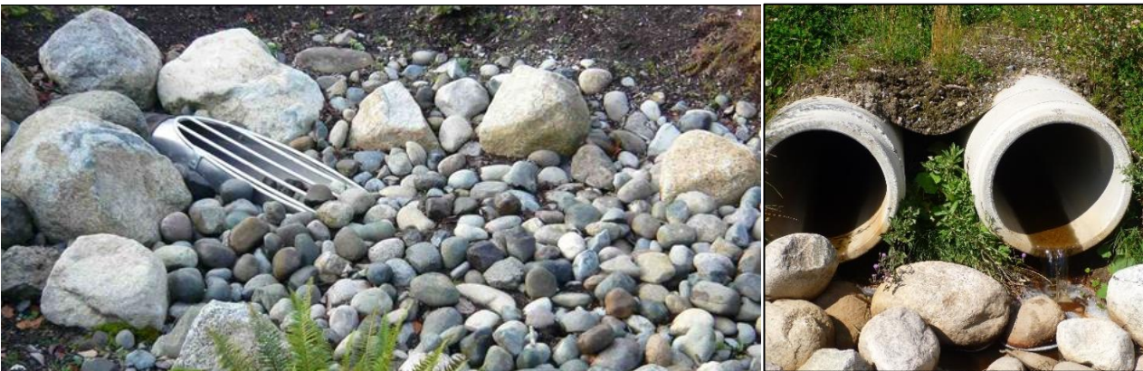
Kuva 64. Hulevesiviemärin purkuputken yhteyteen rakennettu eroosiosuojaus.
