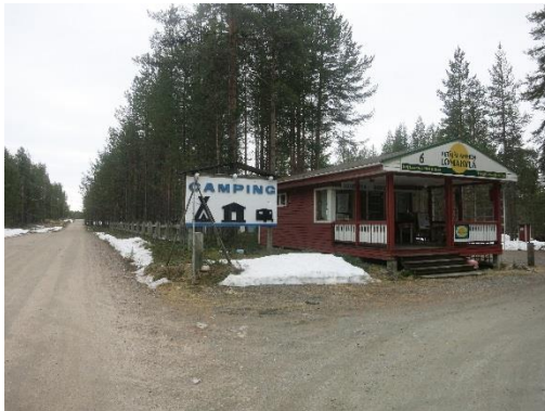
Petäjälinnan lomakylän vastaanotto- rakennus ja leirintämökkejä
