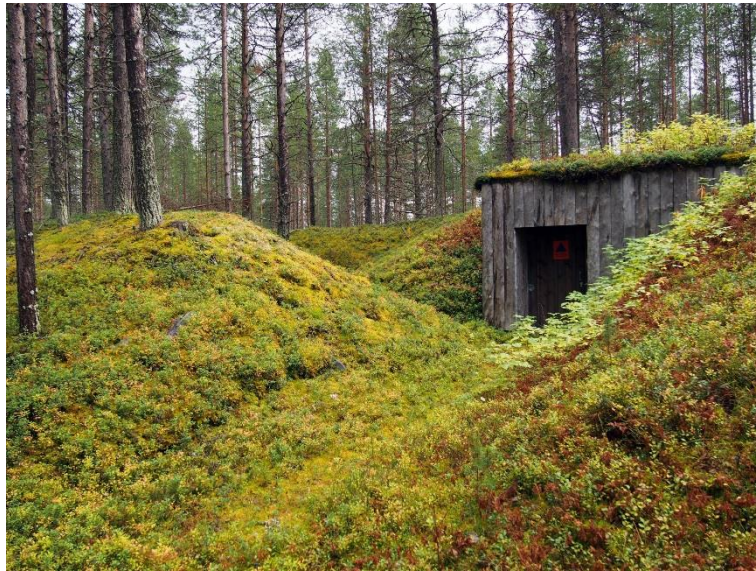
Kuva 11. Entiseen surehkon suojahuoneen jäännökseen on myöhemmin rakennettu hirsivarustus. Ovesa on kyltti "Väestönsuoja - Skyddsrum"
