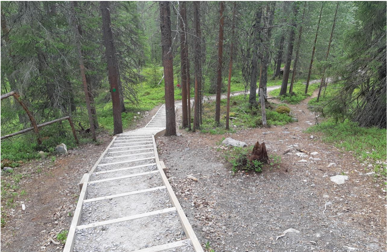
Kuva 16. Valtavaaran laelle nousevalle retkeilyreitille on rinteeseen rakennettu portaat. Maasto on rinteessä ja portaiden ympäristössä kulunut. Portaissa ei mahdu väistämään vastaantulijaa ja nopeimmat oikaisevat portaiden ohi, jolloin syntyy uusia polkuja.
