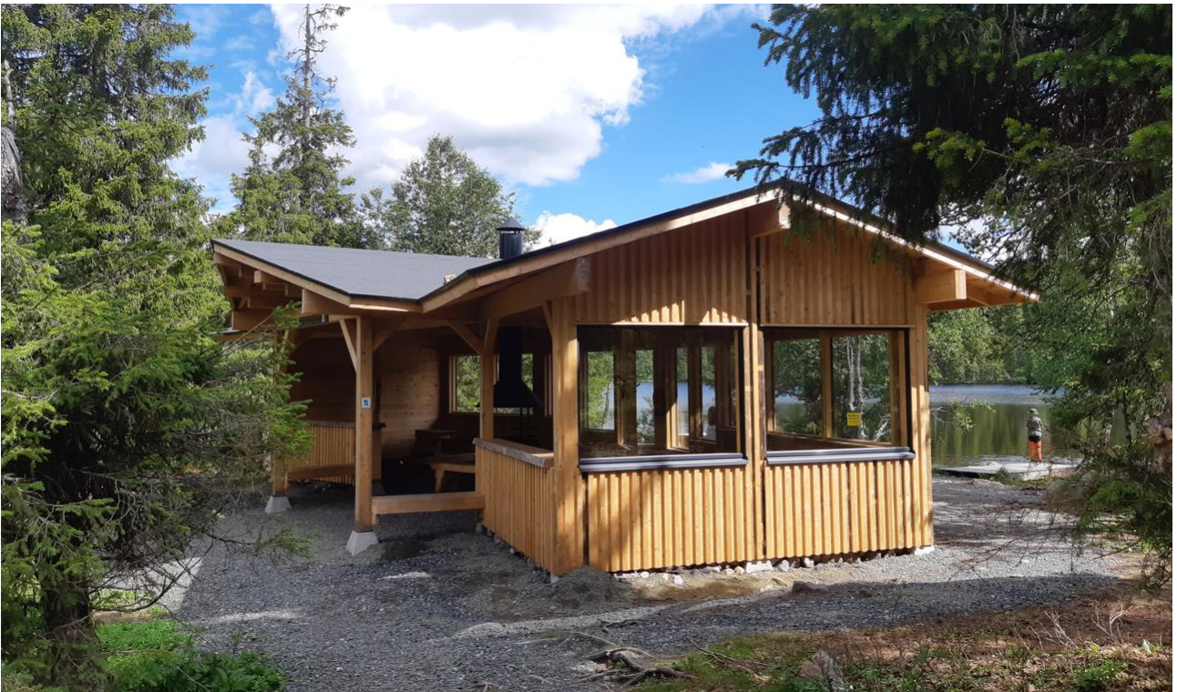
Kuva 25. Taukopaikan uusi rakennus Valtavaaran lammen rannalla. Kulku reiteillä ohjautuu merkityille taukopaikoille, joiden kunnosta tulee huolehtia.
