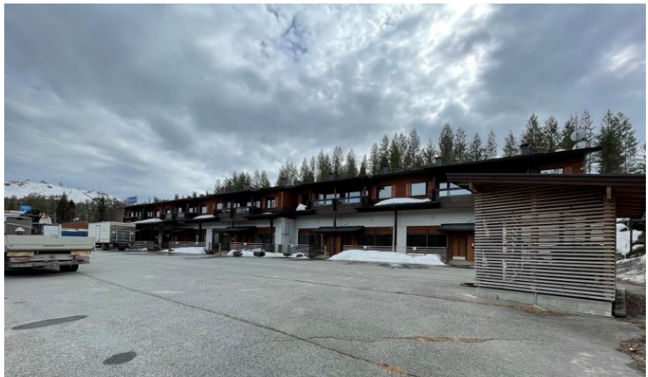
Kuva 1. Suunnittelualueella sijaitseva majoitusrakennus
