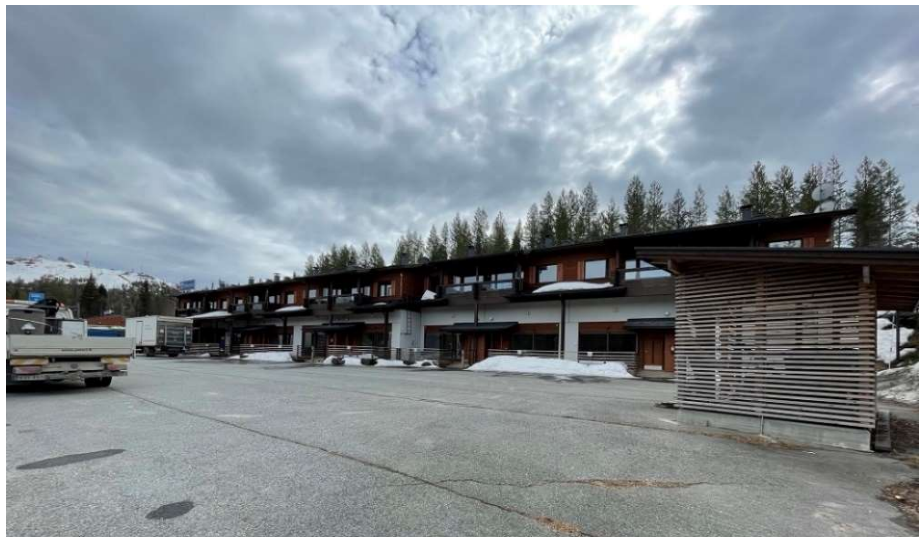
Kuva 1. Suunnittelualueella sijaitseva majoitusrakennus
