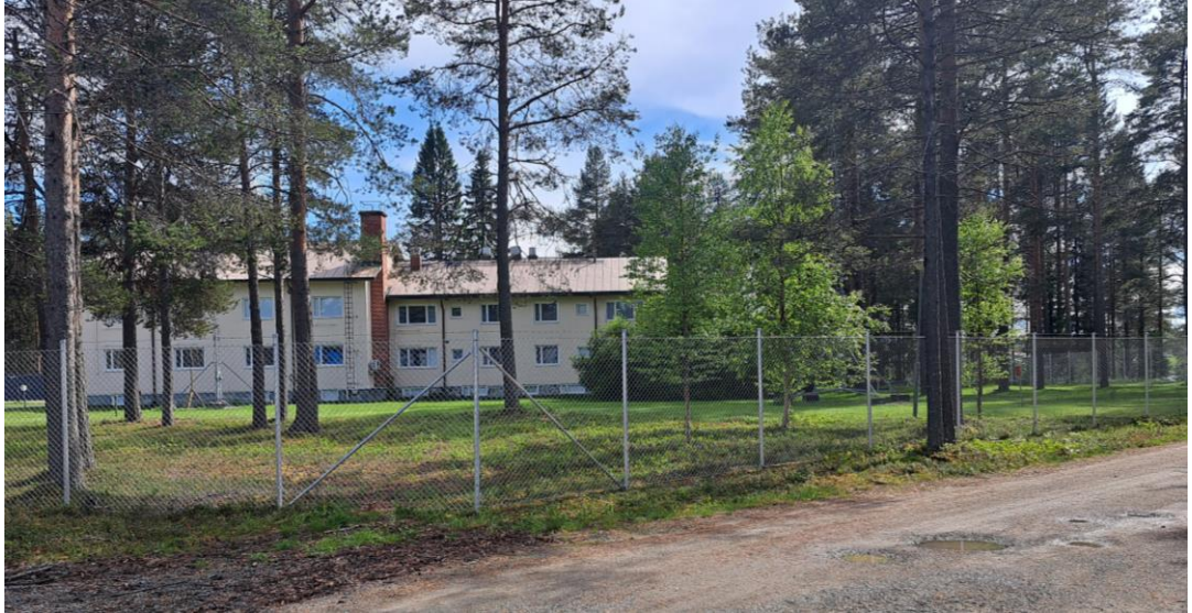
Rajavartiostolaitoksen käytössä oleva rakennus 50-luvun lopulta.
