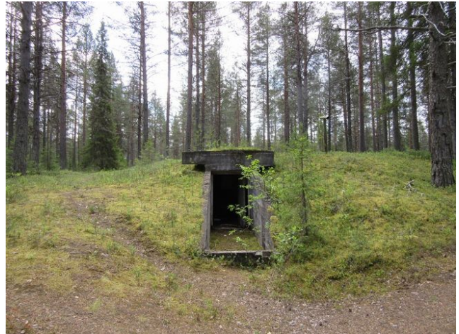
Rakenne 33, kellari etelään.
