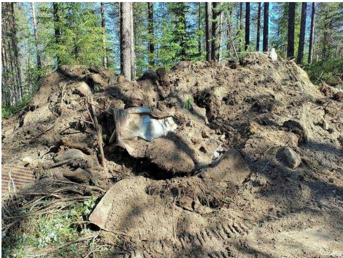
Kuva 8. Kasalle kaivettua jätetäyttöä radan 1 alueelta.
