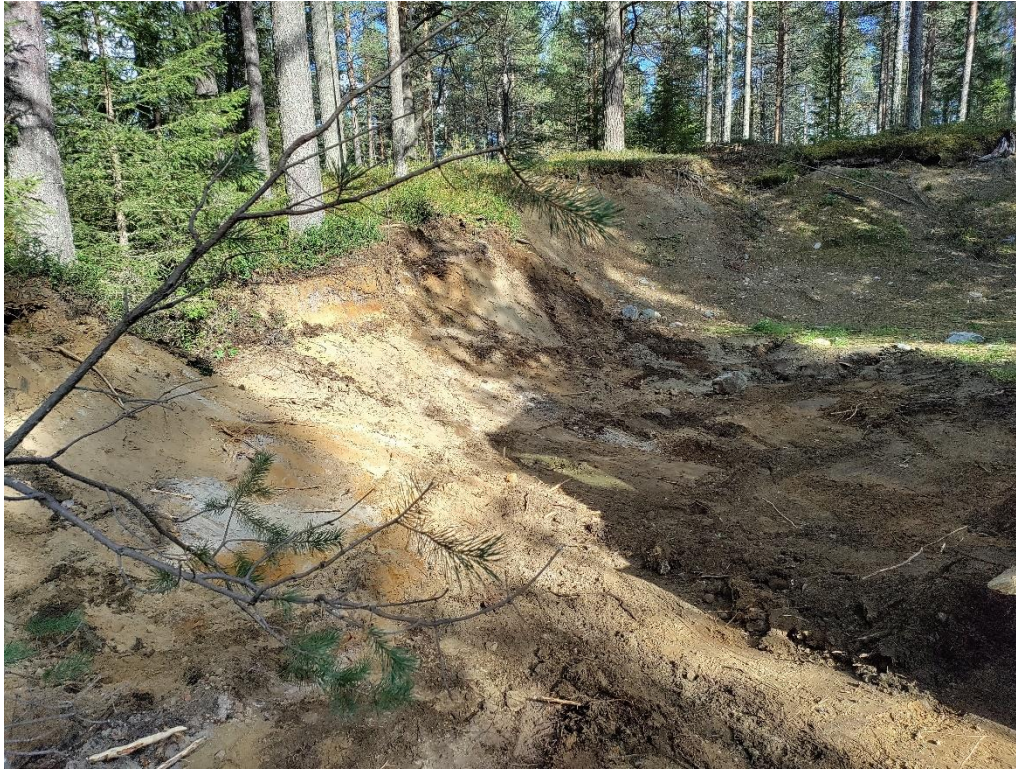
Kuva 5. Rata 1 jätekasan poiston jälkeen.
