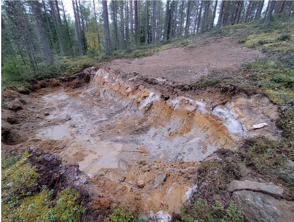
Kuva 3. Rata 2 kaivutyön maksimilaajuudessa.
