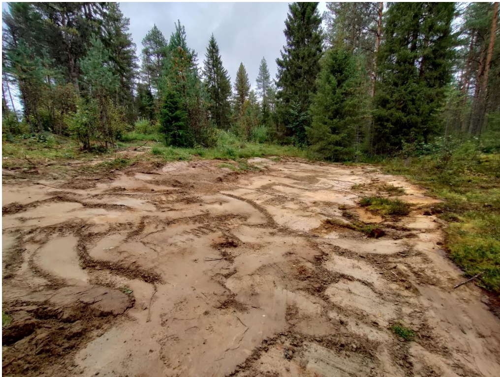
Kuva 2. Rata 3 massanvaihdon jälkeen, pinta tasattuna.
