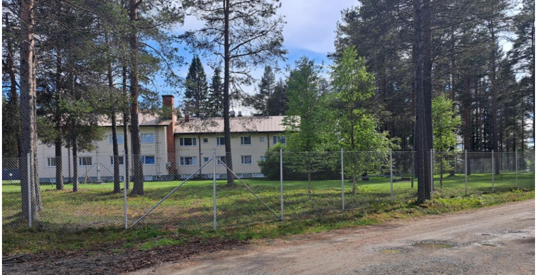
Rajavartiostolaitoksen käytössä oleva rakennus 50-luvun lopulta.
