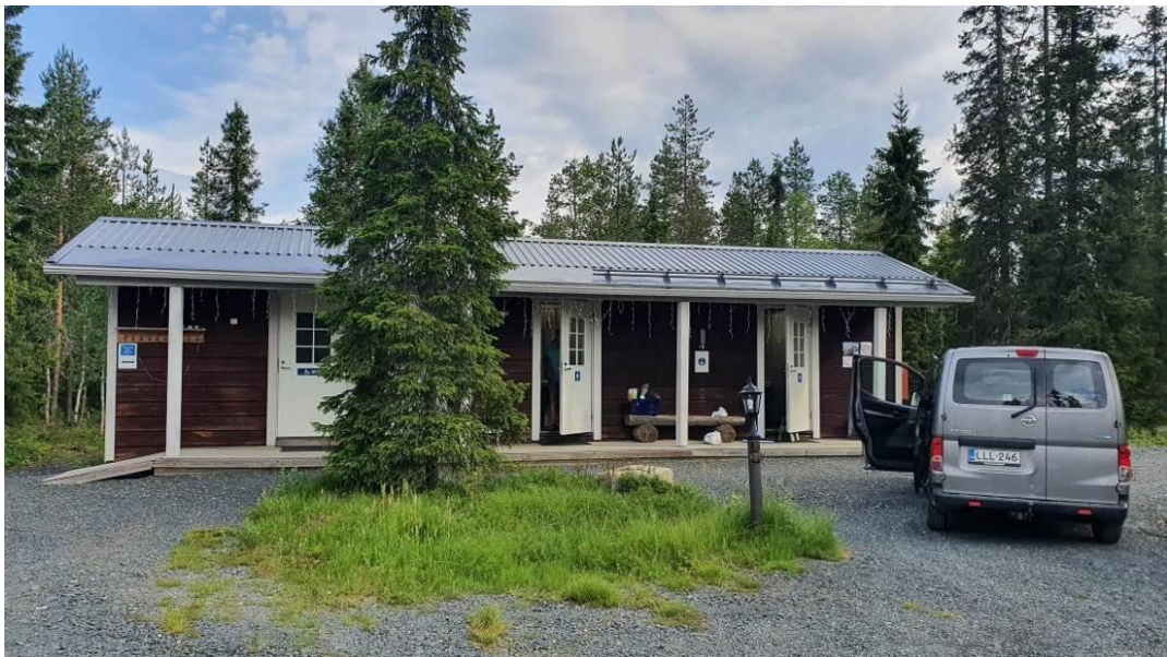
Kuva 14 Merikonteista tehty huoltorakennus (15)
