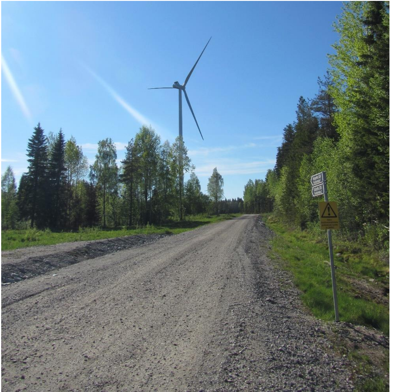
Kuva 2-6. Esimerkki tuulivoima-alueen rakennus- ja huoltotiestä. © AFRY
