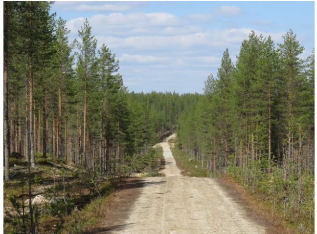
23. Kaapelilinjausta Kurjenjoen pohjoispuolella.
