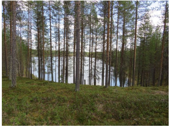
21. Kaapelilinja kulkee Juntuslammen pohjoisrannalla.
