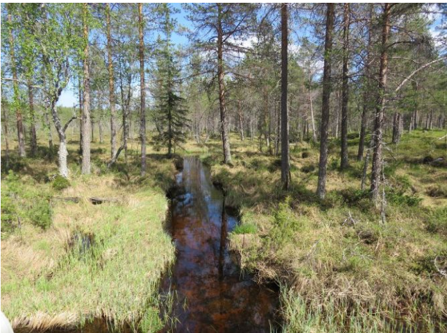
24. Kaapelilinjaus Kurenjoen kohdalla.
