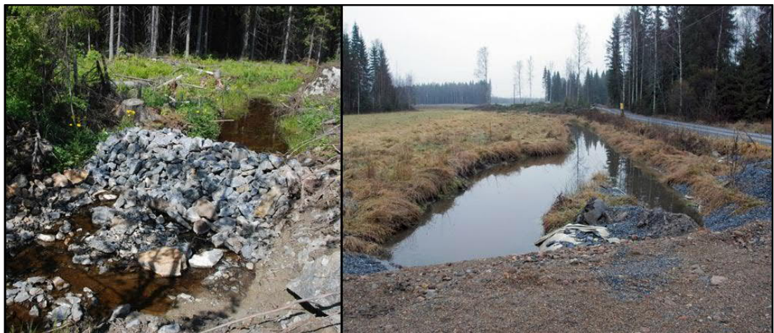
Kuva 9. Esimerkki rakentamisen aikaisesta hulevesien hallinnasta. 7
