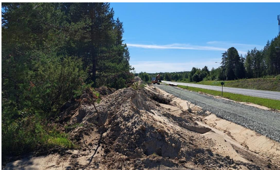
Kuva 5 Uuden kevyen liikenteen väylän rakennustyöt suunnittelualueen länsipuolella Valtatien 5 liikennealueella.
