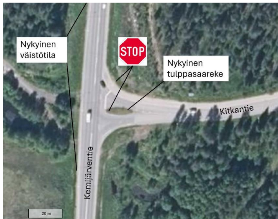
Kuva 8 liittymän nykytilanne (A-insinöörit 28.11.2024).
